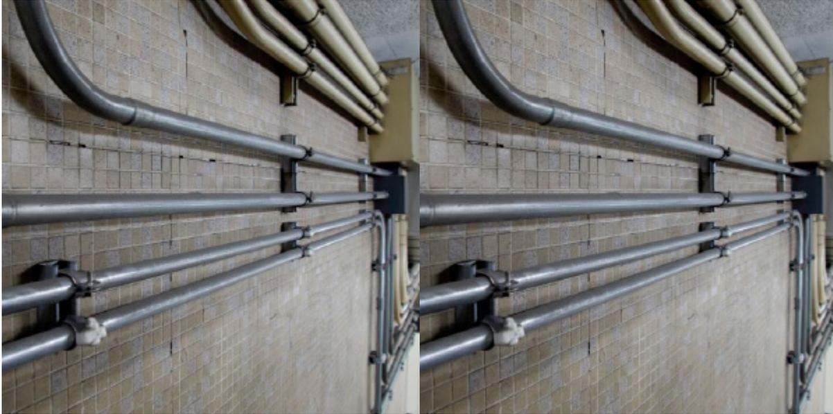
La Tubería Conduit Rígida Galvanizada RMC de 90 mm, fabricada siguiendo las normas IEC 61386-1 e IEC 61386-21, es la solución perfecta para garantizar la seguridad y durabilidad en sus instalaciones eléctricas. Con certificación SEC y un espesor de pared del tubo de 2.5 mm, esta tubería cuenta con hilo y copla que facilitan su instalación y proporcionan un ajuste seguro y óptimo.
