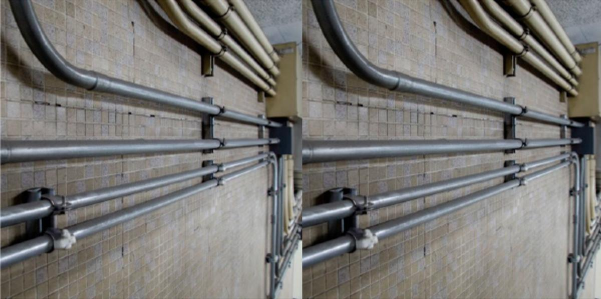
La Tubería Conduit Rígida Galvanizada RMC/ANSI de 63 mm, fabricada siguiendo las normas IEC 61386-1 e IEC 61386-21, es la solución perfecta para garantizar la seguridad y durabilidad en sus instalaciones eléctricas. Con certificación SEC y un espesor de pared del tubo de 2.5 mm, esta tubería cuenta con hilo y copla que facilitan su instalación y proporcionan un ajuste seguro y óptimo.
