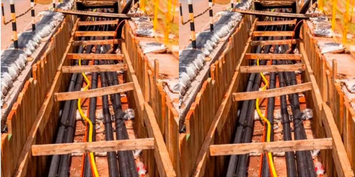
El cable de Aluminio Subterráneo marca BAKER KABEL está diseñado para líneas de distribución eléctrica subterránea en baja tensión, este cable está compuesto por varios hilos de aluminio unidos en forma helicoidal, recubierto con aislamiento de polietileno reticulado XLPE y una envoltura de cloruro polivinilo (PVC). Cuenta con normativas de fabricación IEC 60502-1.
