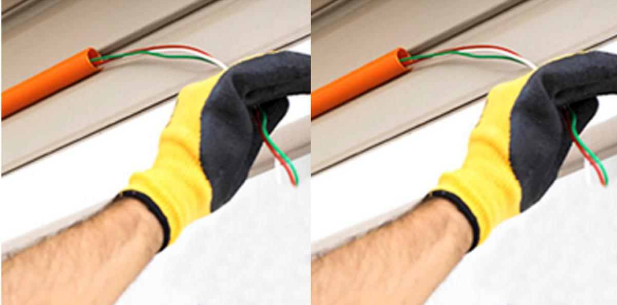
Línea Schedule cuenta con espesor mucho mayor a la tubería convencional de PVC, lo que permite un mejor comportamiento a la presión mecánica. Retardante a la llama, resistente a la corrosión y ácidos del suelo. Ideal para ser usadas en instalaciones subterráneas
